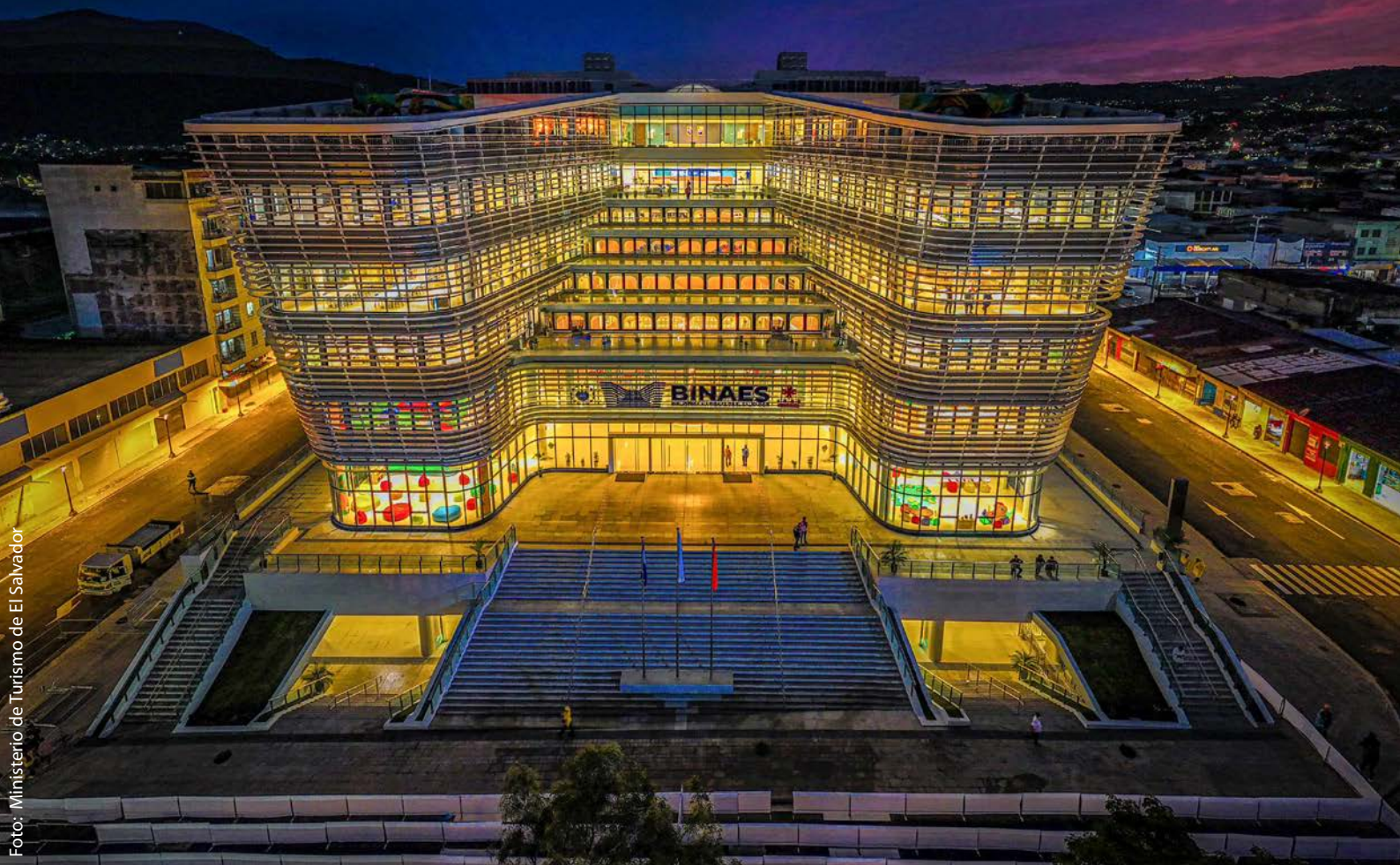
Vista exterior de la nueva Biblioteca nacional situada en el corazón de San Salvador.
